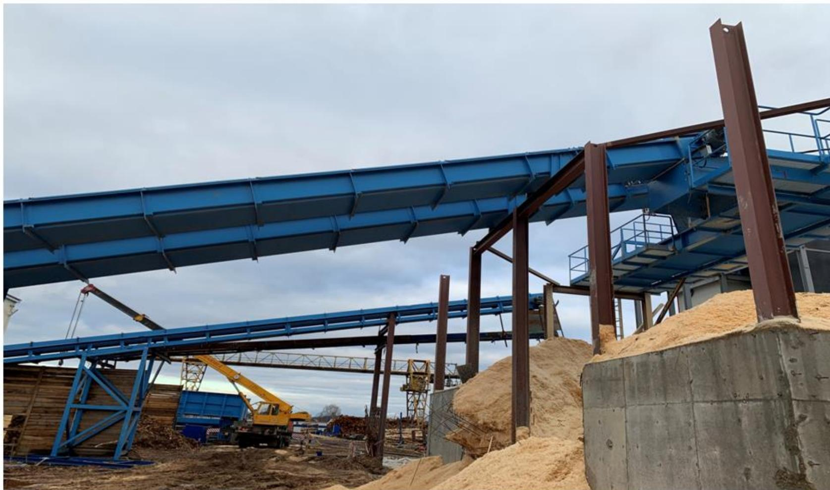
Сушильный комплекс для сушки пиломатериалов из 10 шт. марки SECAL, работающий от котельной предприятия: 10 блок-камер по 200 м<sup>3</sup> каждая (объем разовой загрузки 2000 м<sup>3</sup>)
