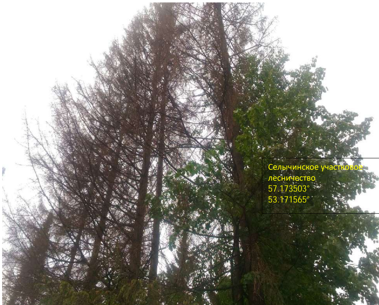
Аварийные деревья квартал 41 выдел 1
